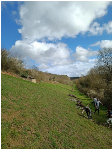
Arrachage de vignes éparses, sous la cabane des Treilles.
